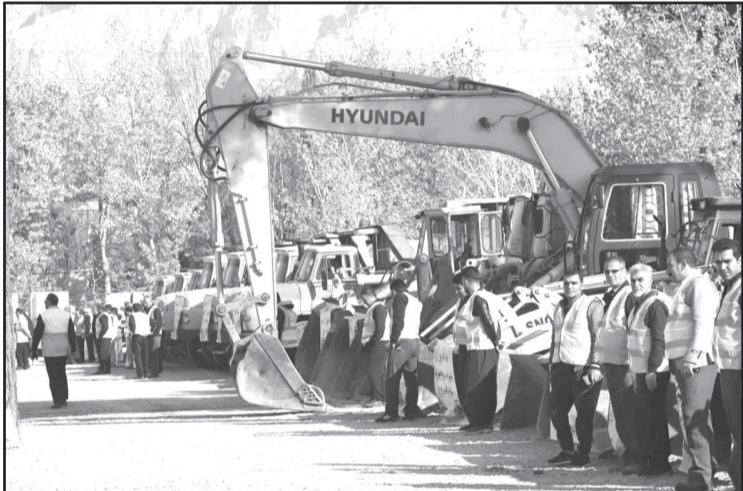
عملیات اجرایی در یکی از مناطق کرمانشاه
