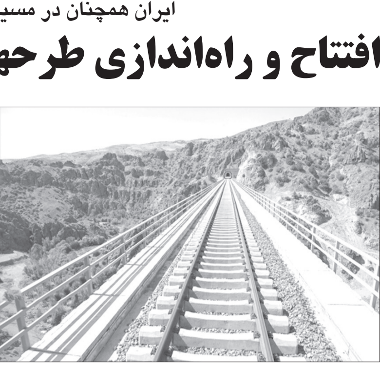
خط راه آهن اردبیل در حال ساخت است.
