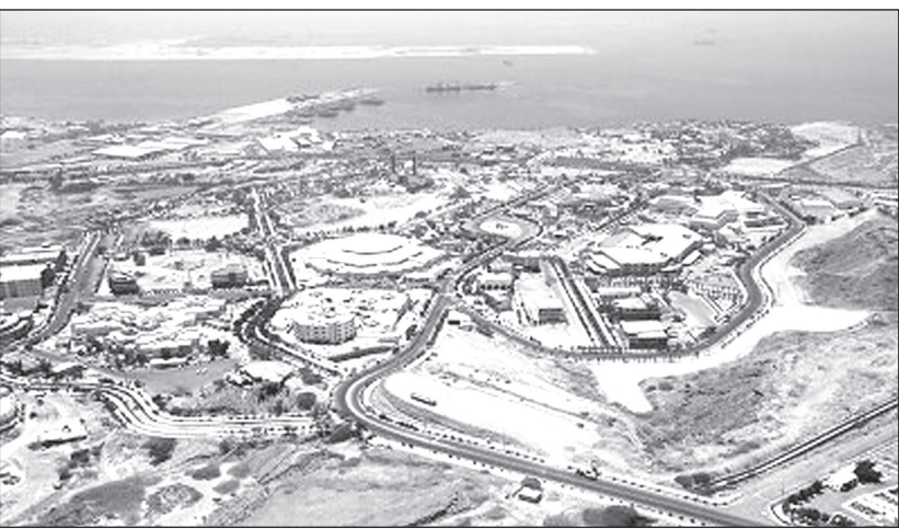
نمای هوایی از شهرک صنعتی و خدماتی رازی قائم شهر
